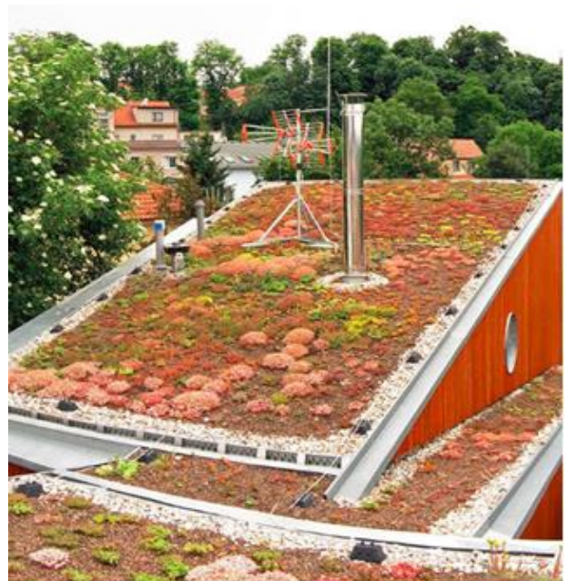
Příklad zelené střechy ( opatreni-adaptace.cz )
